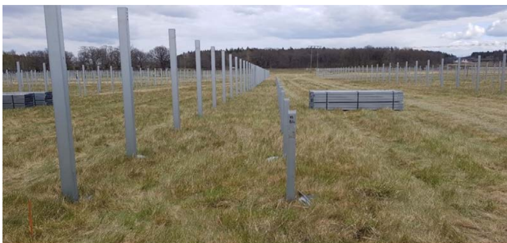
Figur 3 Bild på pålade markstolpar (EnergiEngagemang 2024).
